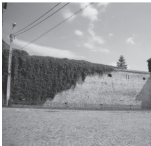
▪ Zidul sudic văzut din exterior
